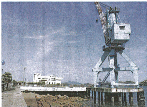
支柱の付け替えなどで補強した玉野工場の岸壁
