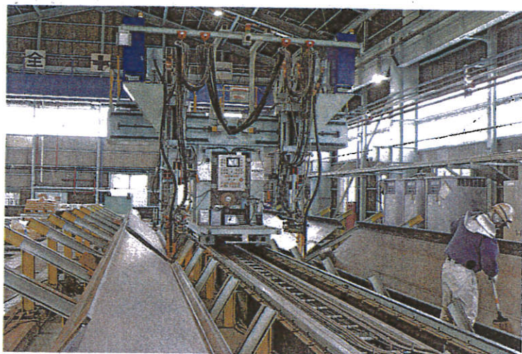
桂スチールの玉野工場で稼働中の自動溶接機。新工場では新型機を導入する
