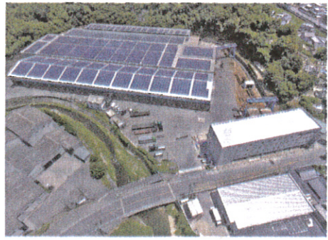
竣工した新事務所棟と社員寮(右下)
