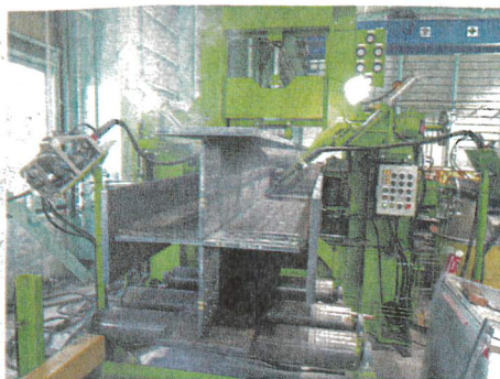
十字柱の製作風景
