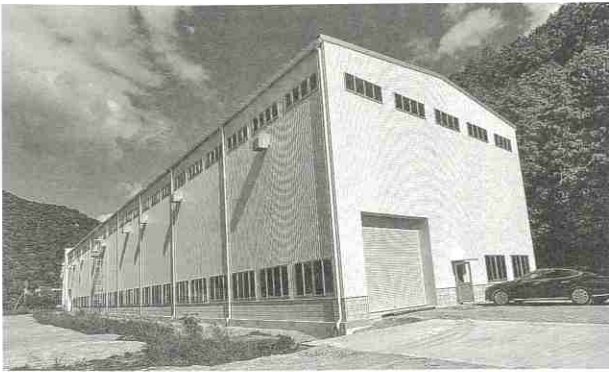
完成した新倉庫
